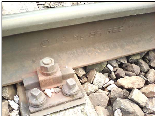
Detail upevnění kolejnic
